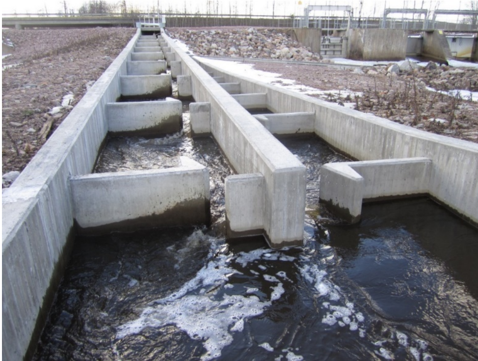
Figur 31. Denna slitsränna avbördar ca 400 l/s med 12 cm fall per slits. Bassängerna är 3,35 m långa och 1,8 m breda. Foto: Fiskevårdsteknik.
