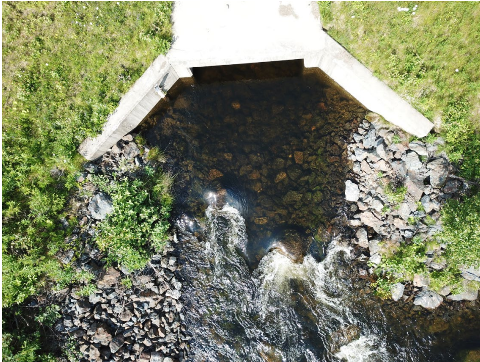
Figur 35. En flödesbestämmande tröskel är placerad bakom utskovet varvid höga vattenhastigheter i omlöpet undviks. Foto: Mattias Olsson, Länsstyrelsen Västernorrlands län.
