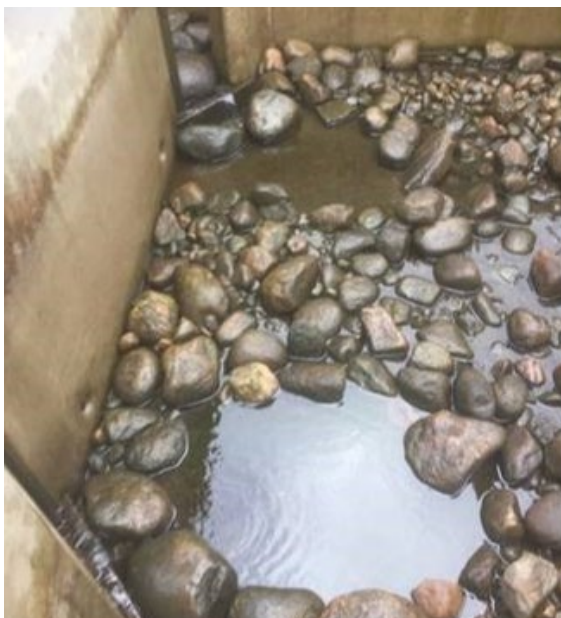
Figur 33. Slitsränna där bottenmaterialet till viss del spolats bort. Foto: Fredrik Nilsson, Länsstyrelsen Västra Götalands län.
