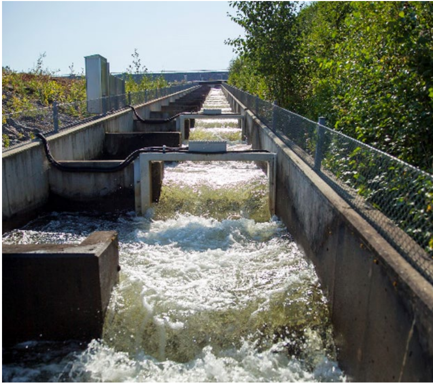
Figur 23. Bassängtrappa utrustad med PIT-tag antenner för registrering av återvandrande märkt lax och öring. Foto: Linda Vikström.
