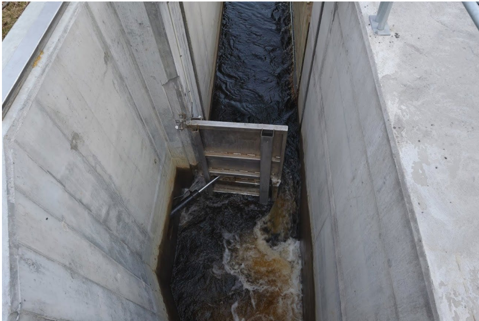
Figur 57. Flyktöppning och klafflucka. Slitsöppningen i luckan är 30 cm bred och 65 cm djup vid normalvattenstånd. Luckan avbördar ca 400 l/s i stängt läge. Foto: Fiskevårdsteknik.
