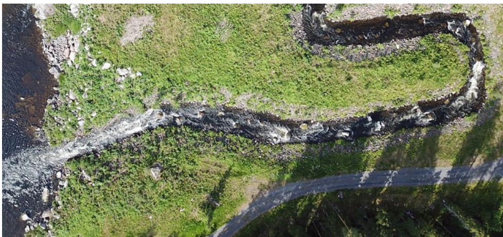
Figur 34. Omlöp utformat som en blockrik bäck. Foto: Mattias Olsson, Länsstyrelsen Västernorrland
