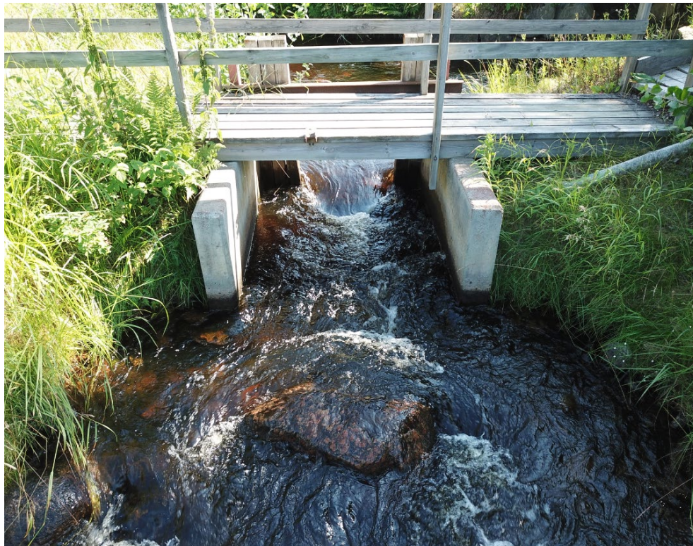
Figur 36. Flödesbestämmande tröskel i form av ett stenblock. Foto: Mattias Olsson, Länsstyrelsen Västernorrlands län.
