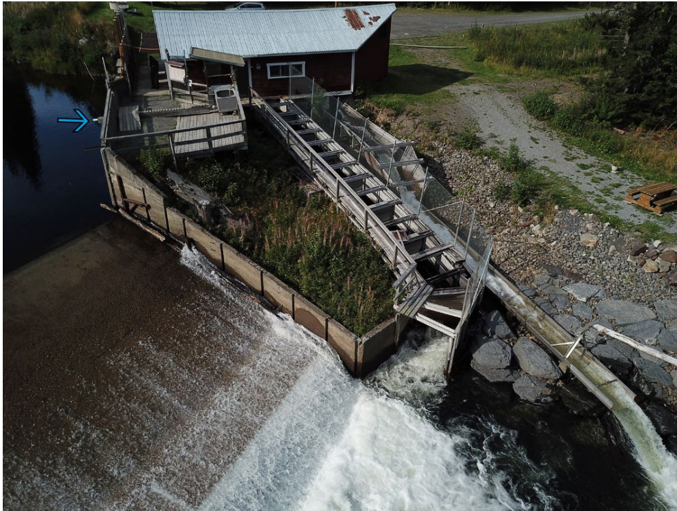
Figur 21. Vinkelrät mynning vilket ger ett kort anlockningsflöde vilket i detta fall förmodligen kan vara svårt för fisken att identifiera givet turbulensen och vattenhastigheten i området utanför mynningen (ingången för uppströmsvandrande fisk). Foto: Mattias Olsson, Länsstyrelsen Västernorrlands län.
