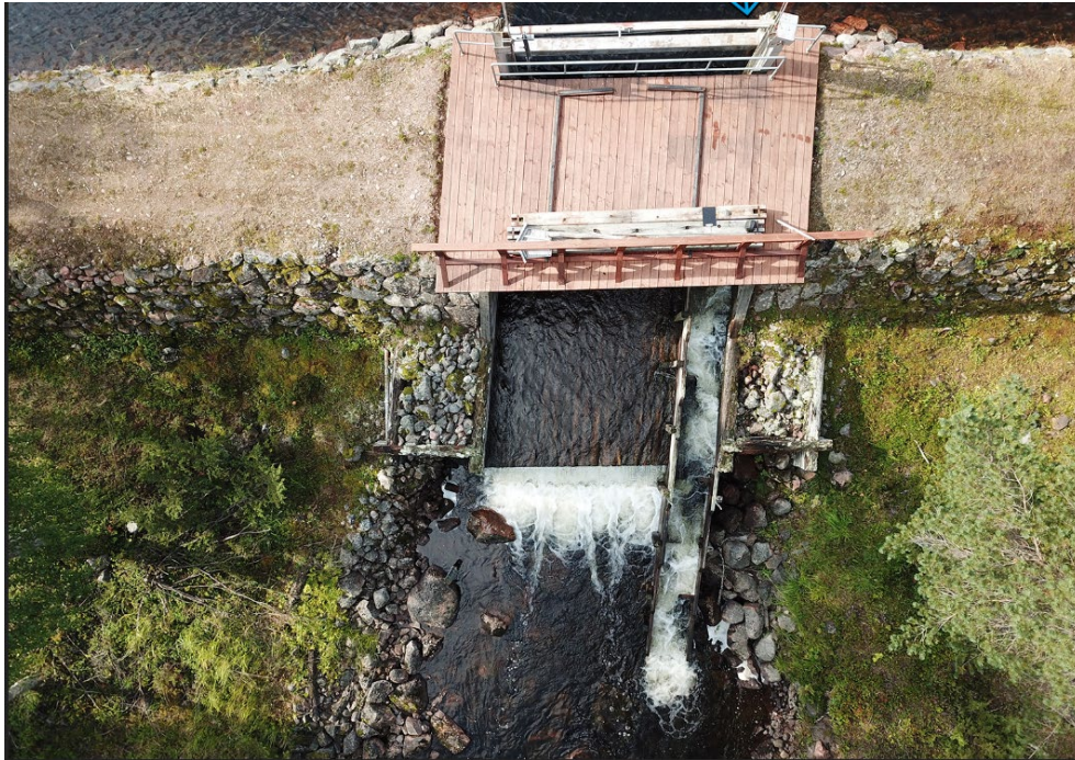
Figur 22. Myrning parallellt med huvudflödet. Foto: Mattias Olsson, Länsstyrelsen Västernorrland.
