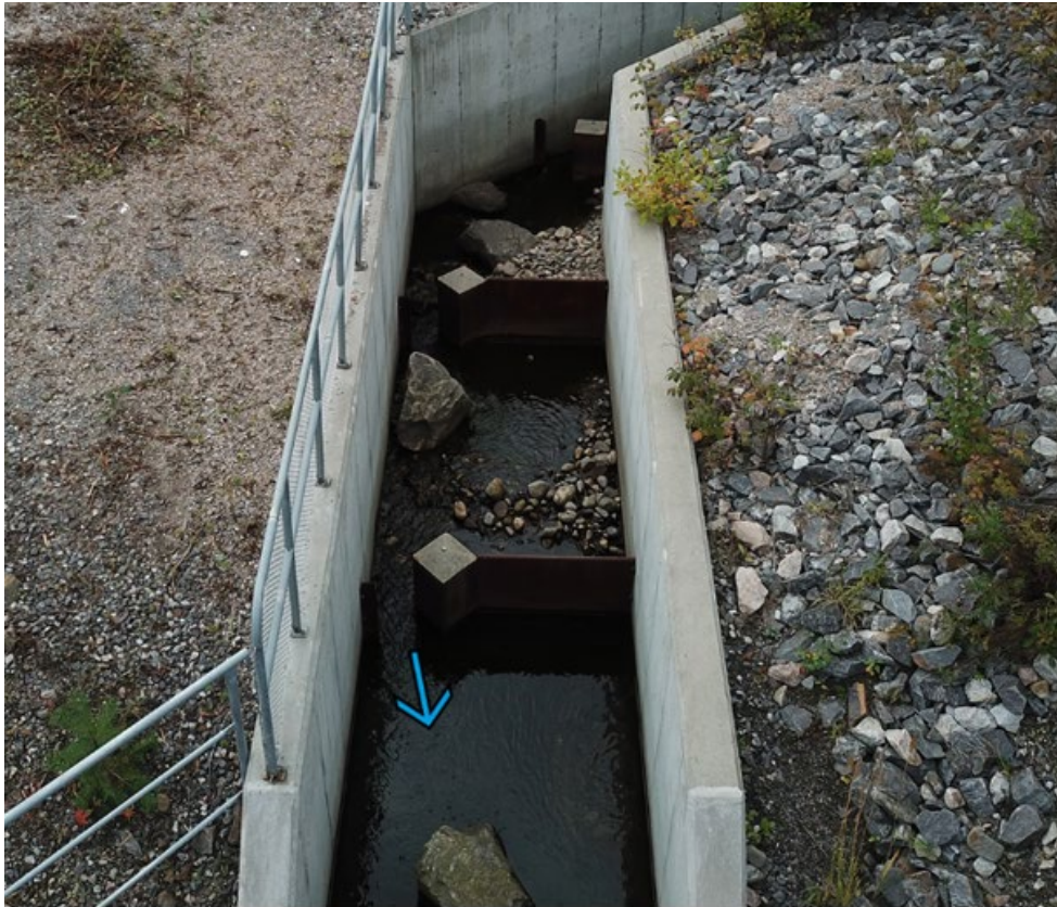
Figur 32. Slitsränna med struktur på botten. Foto: Mattias Olsson, Länsstyrelsen Västernorrland.
