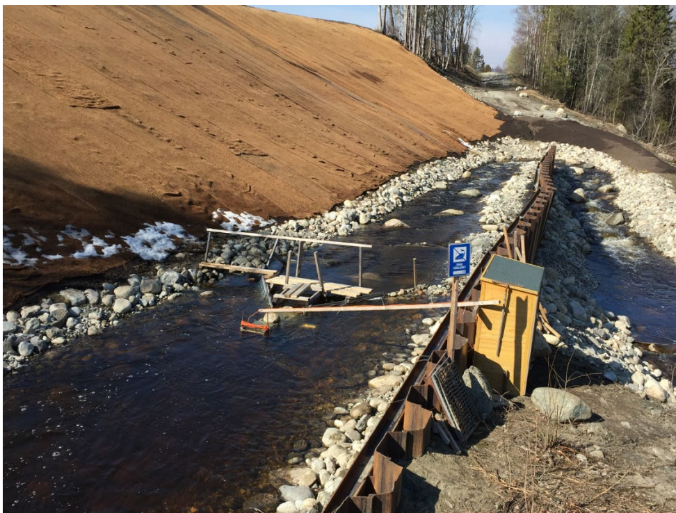
Figur 27. Exempel på schaktslänter vid omlöp. Foto: Länsstyrelsen Jämtland.
