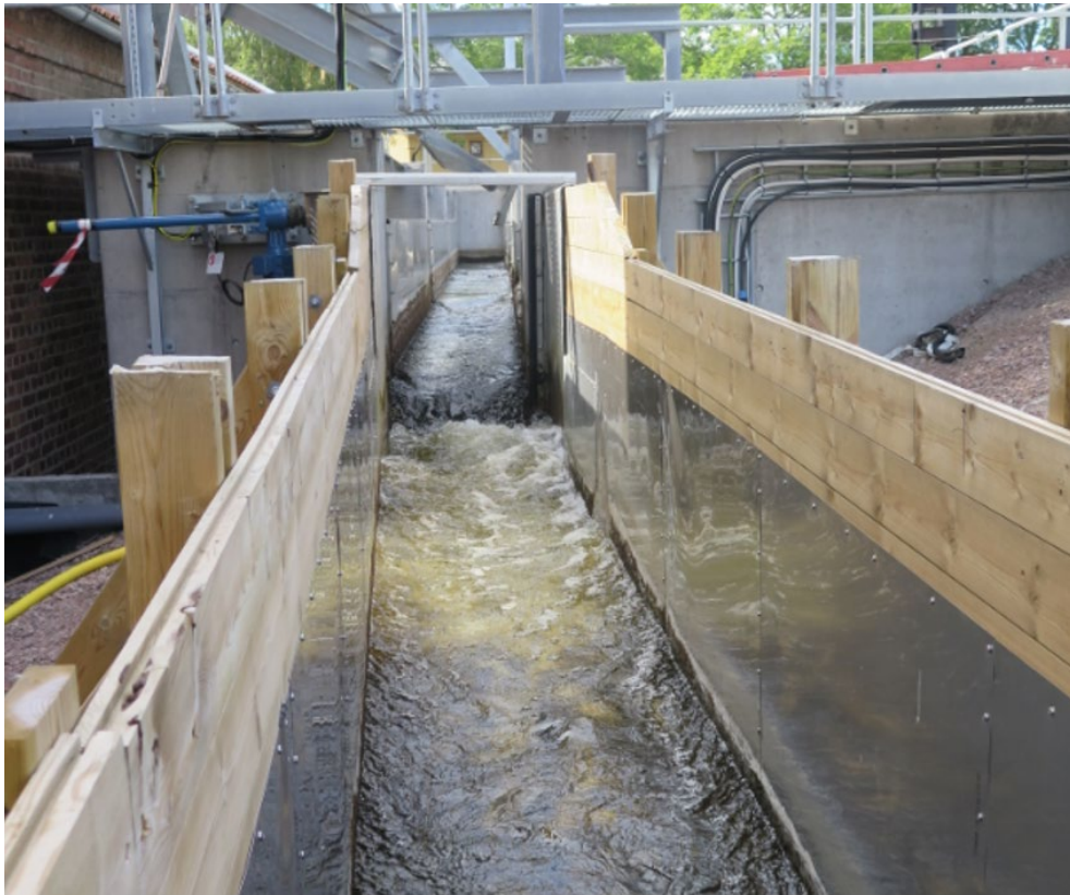
Figur 59. Flykträna i form av öppen ränna. Foto: Johan Lind, Mälarenergi.
