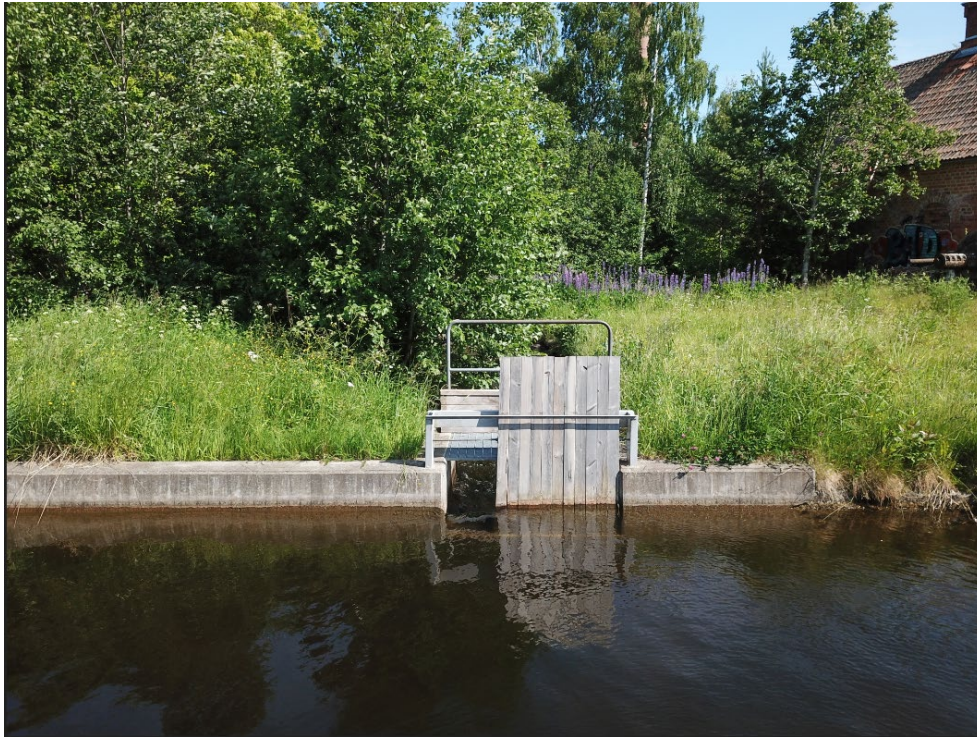
Figur 20. Enkel reglering av inflöde till passage via sättar. Foto: Mattias Olsson, Länsstyrelsen Västernorrlands län.
