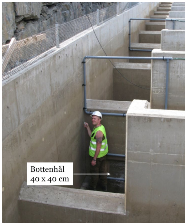
Figur 24. Bassängtrappa med nedsänkning och bottenhål. Foto: Lo Persson.
