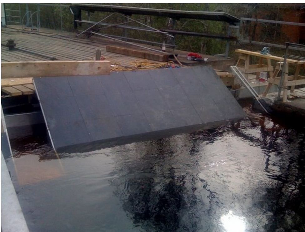
Figur 56. Överdelen av ett alfa-galler som består av en solid platta som skapar en strömrefug för fisk. Flödet regleras nedströms flyktöppningarna genom en reglerbar tröskel. Foto: Fiskevårdsteknik
