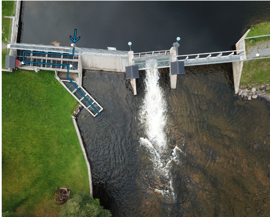
Figur 15. Placering av ingången på den djupa sidan ökar chansen att fisken ska kunna hitta ingången till passagen. I detta fall saknas dock tydligt anlockningsflöde vilket skulle behöva tillföras under vandringsperiod. Foto: Mattias Olsson, Länsstyrelsen Västernorrland.
