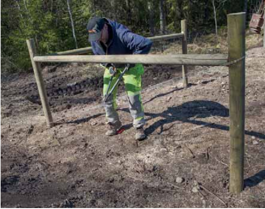
Bild 61. Spänn ihop hörnet med Gripple-tången så att det blir hårt och trådarna väl spända.
