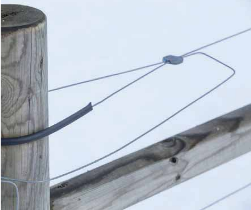
Bild 75. Man kan använda Gripplar istället för att göra egna knutar, men det blir betydligt dyrare.
