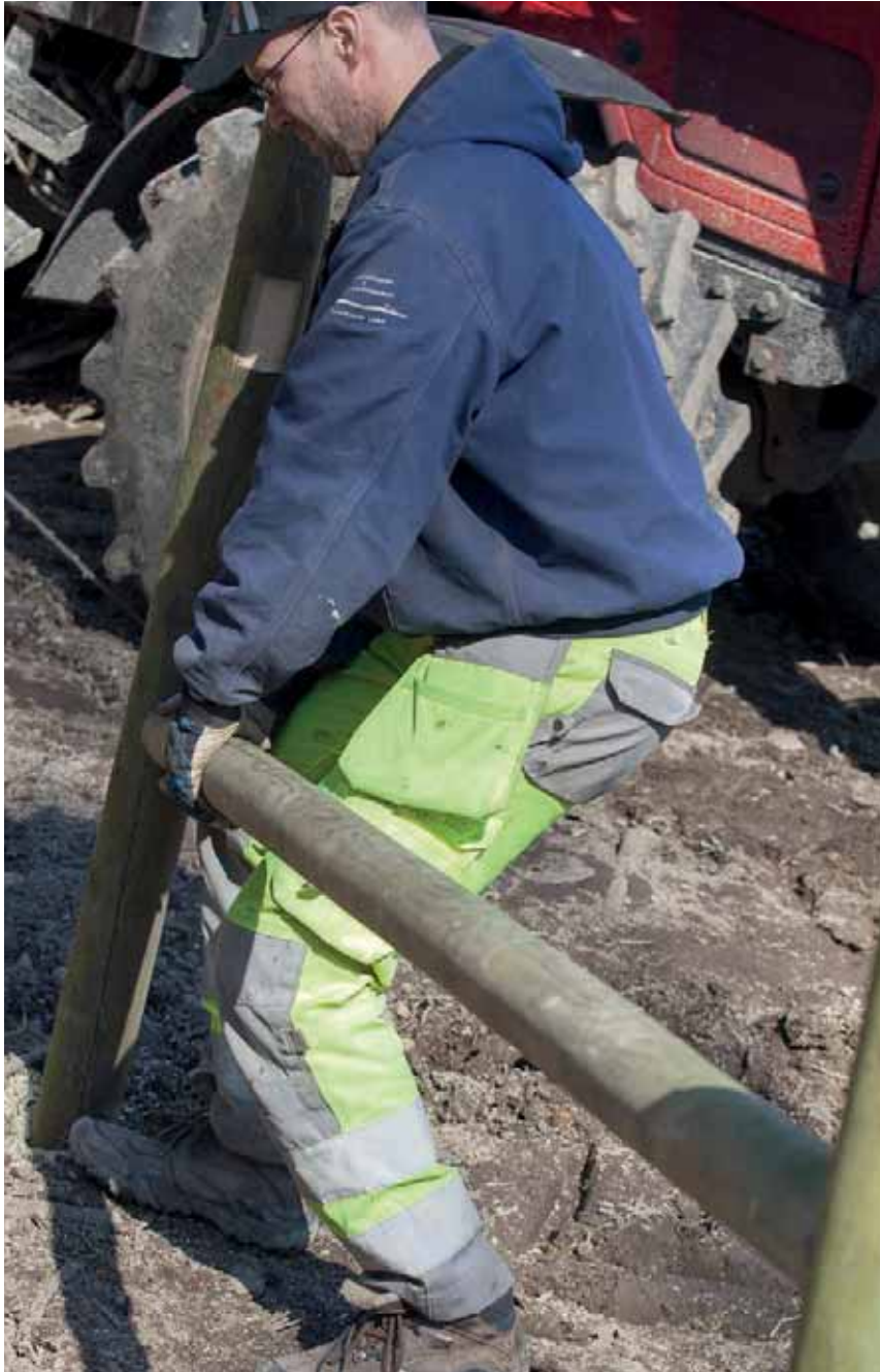
Bild 49. Sätt överliggaren på plats.
