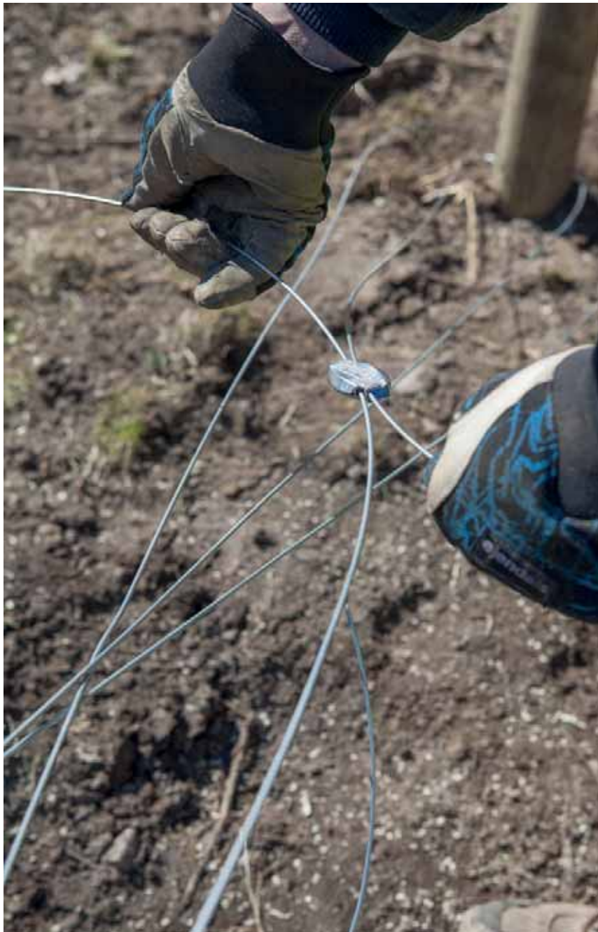
Bild 58. Fäst ihop åttan med en Gripple på mitten. Dra åt för hand först.
