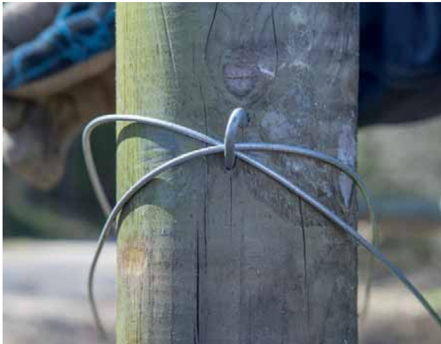
Bild 59. Kontrollera trådarna vid märklan så att de inte korsar varandra.
