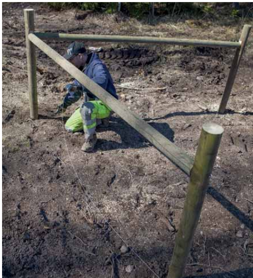
Bild 55–57. Trä i spänntråden, den ska sitta som i en åtta.
