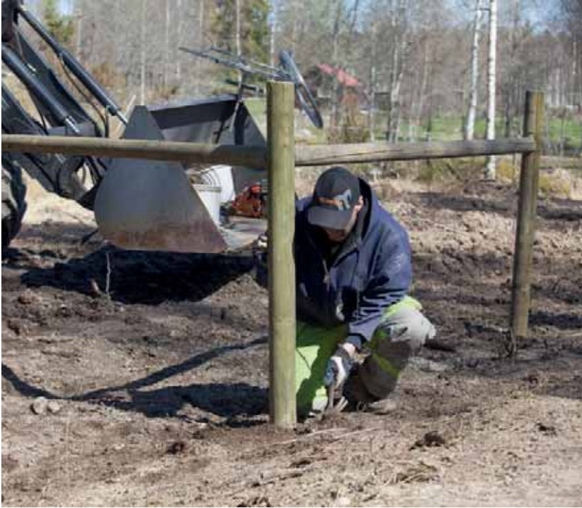
Bild 52. Fäst märklorna för späntråden (åttan) längst ned på stolpen i hörnet. OBS! En märkla i varje riktning. Se även skisserna i bilderna 54 och 66. Spika in halva märklan och lämna en bit öppen så du kan dra igenom tråden som ska hålla ihop hörnet (späntråden).
