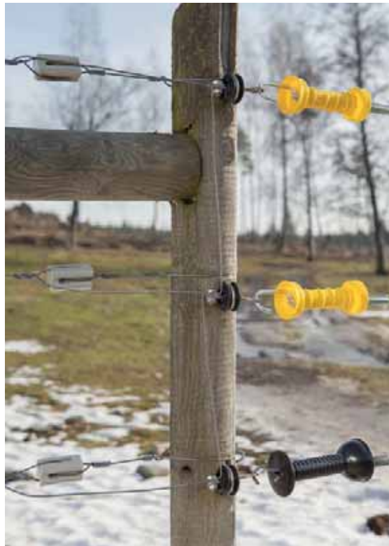
Bild 80. Vidarekoppling av strömtrådarna vid grindankare.
