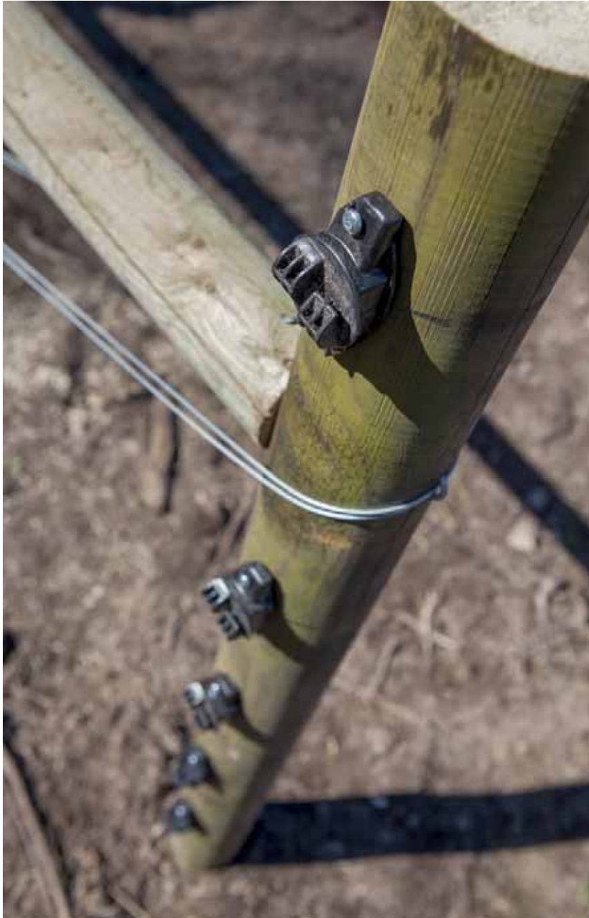
Bild 68. Skruva upp långtidsisolatorerna med en skruv i översta hålet till en början. Då kan man vrida isolatorn vid montering av tråden.
