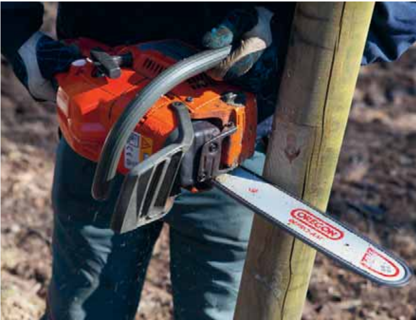
Bild 46. Såga ur lite kring markeringen på stolpen med motorsåg, fogsavns eller yx/kniv. Fäll in överliggaren på platsen. OBS! Montörens vänstertumme ska hållas ner runt motorsågsbågen.
