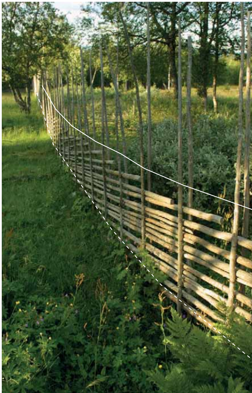
Bild 98. Placera en eltråd 10–15 cm över den övre slanan. Om gärdesgården är gles monteras även en låg tråd 30 cm från marken.
