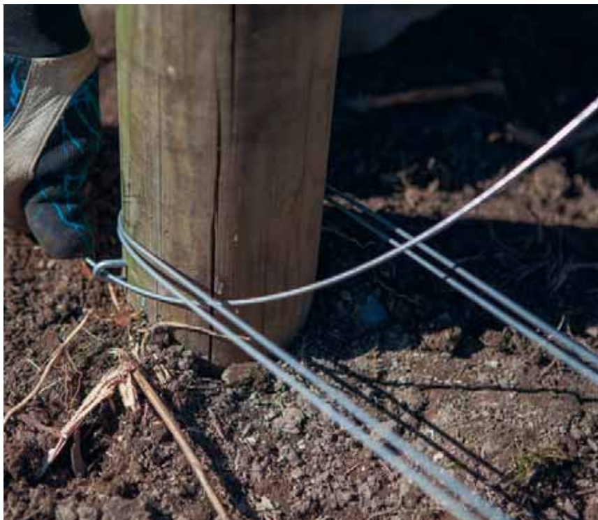
Bild 64. Trä spänntråden från hörnstolpen mot stolpen i den andra riktningen som bilden visar.
