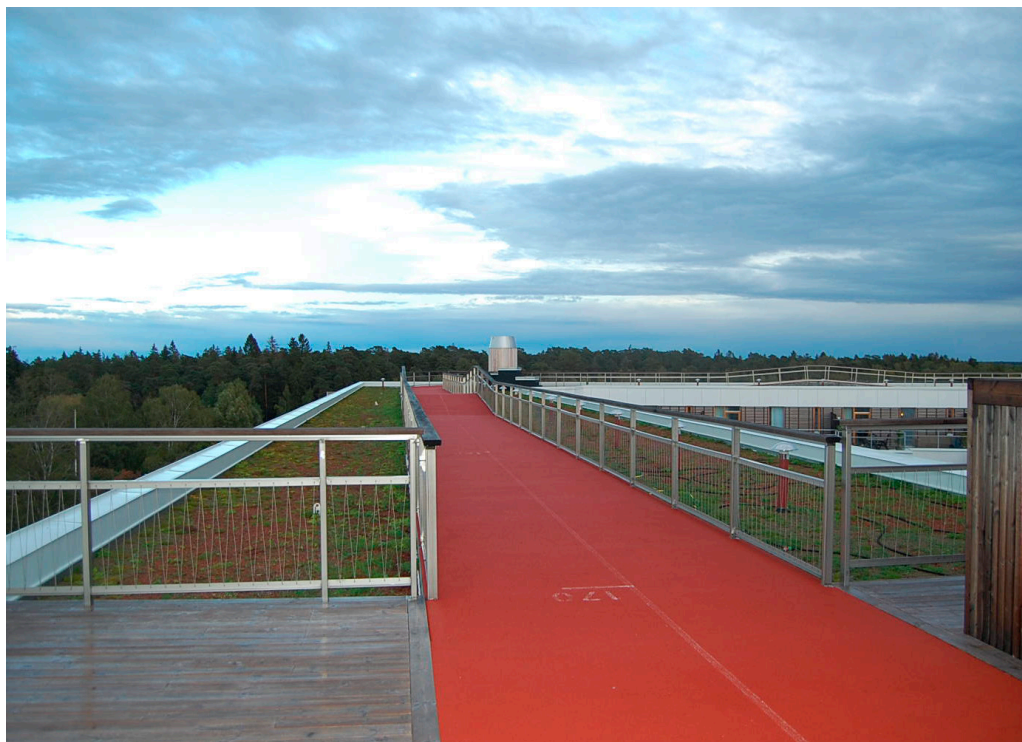
Löparbana på tak, på fastigheten Inspiration Rosendal i Uppsala. Foto: Niklas Aldén.
