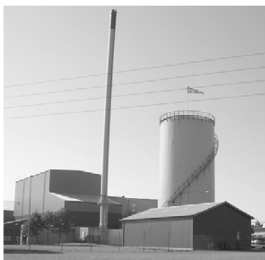
Bild A13. Haslev Kraftvarmeværk, observera den stora ackumulatortanken.
