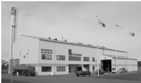
Bild A4. Sätenäs värmeverk.
