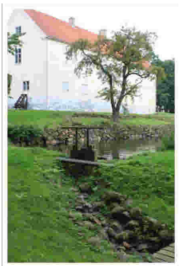
Figur 18. Dammen öster om mangårds-byggnaden, med den dämninganordning som finns där idag. (Foto: Boel Persson, 2011-09-05)
