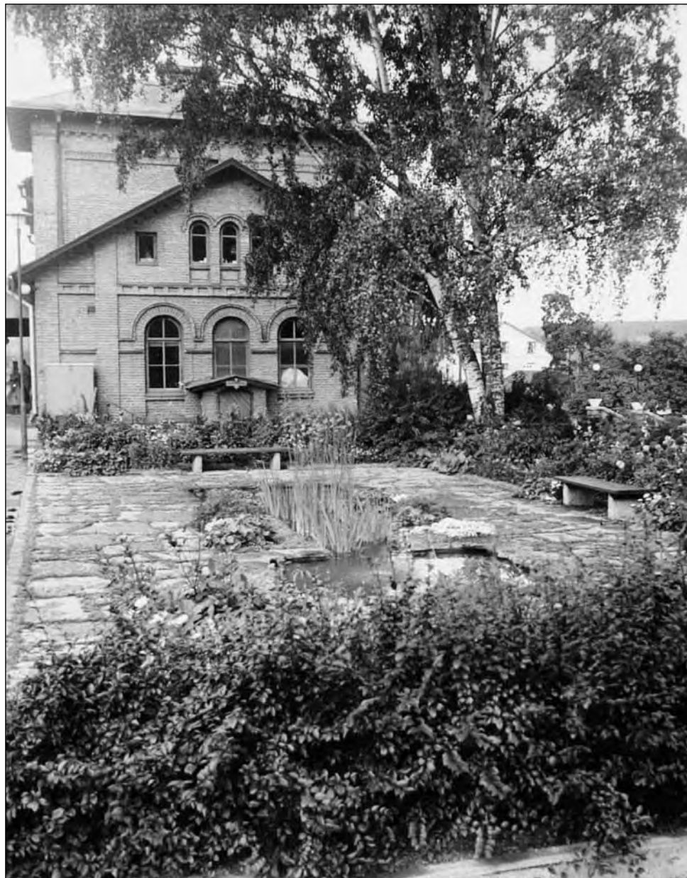
Stationsanläggning i Sollefteå, Ångermanland, från 1944. Två kvadratiska vattenspeglar omges av en kalkstensbeläggning och en strikt perennplantering med ett vattenväxtparti i mitten.
